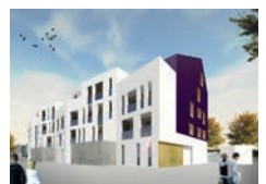
résidence Florescence à Pont-à-Mousson, adaptée pour des personnes âgées et à mobilité réduite
